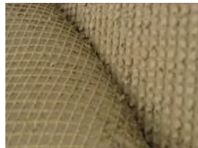
Obr. 5 – Odtržení síťoviny
