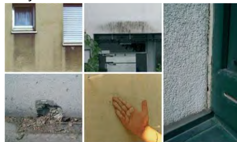
Obr. 1 – Kontrola povrchu ETICS1
