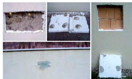
Obr. 2 – Sondy do zateplovacího systému
