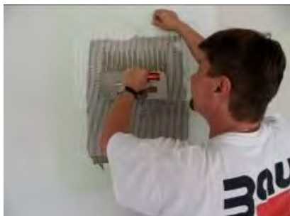
Obr. 3 – Nanesení lepicí hmoty
