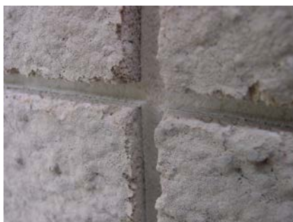
Obr. 47 – Vyfrézované drážky
