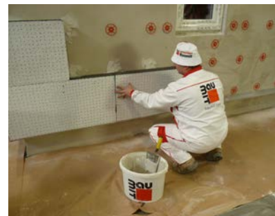
Obr. 39 - Lepení tepelně izolační desky
