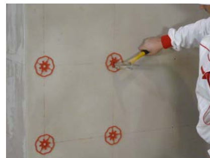
Obr. 36 - Aktivace kotvy StarTrack Red
