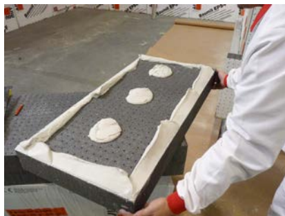
Obr. 38 - Nanášení lepidla na tepelně izolační desku
