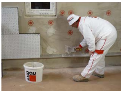
Obr. 37 - Nanášení lepidla na kotvy StarTrack
