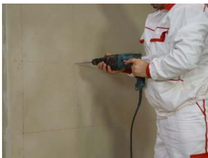
Obr. 35 - Vrtání otvorů pro kotvy
