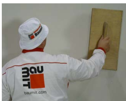
Obr. 32 – Broušení základní vrstvy
