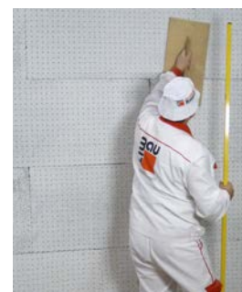
Obr. 21 – Broušení fasádních desek
