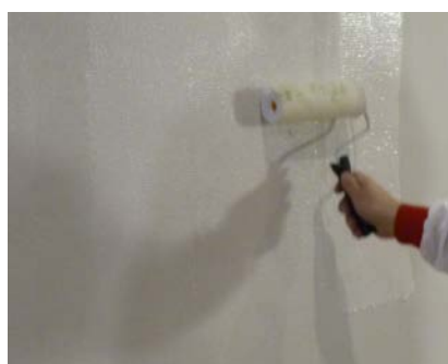
Obr. 33 – Provádění základního nátěru
