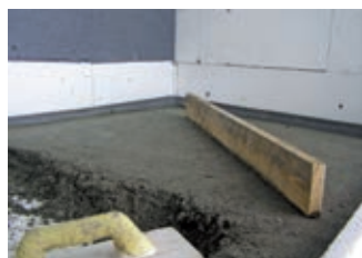
Realizace cementového potěru
