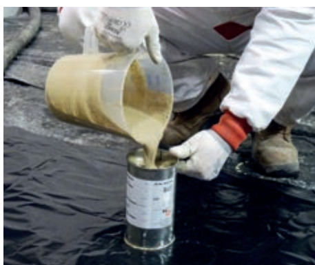
Položení separační fólie a ověření správné konzistence lité směsi rozlivovou zkouškou
