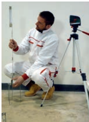
Zaměření nivelety a stanovení výšky podlahové konstrukce pomocí nivelačního laseru, hadicové vodováhy apod.
