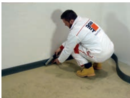
Osazení okrajové dilatace
