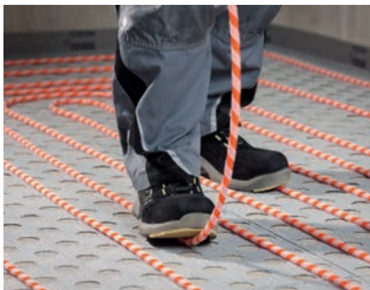
pokládka a fixace trubek podlahové vytápění
