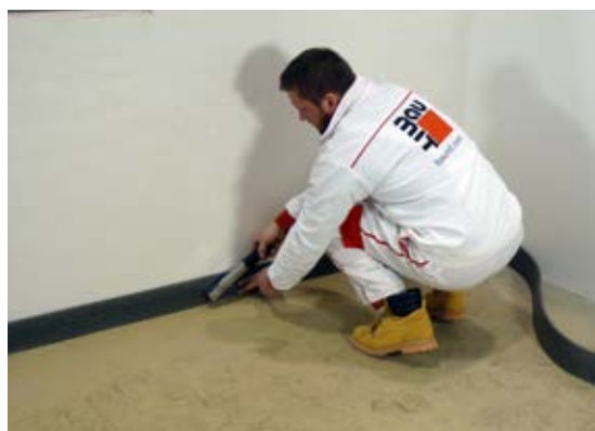
Montáž okrajové dilatační pásky, pokládka systému podlahového vytápění
