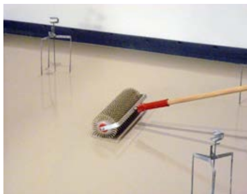
Vibrační lať a ježatý odvzdušňovací válec
