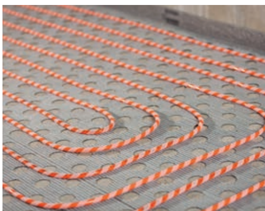
připravenost otopného systému před litím podlahové stěrky
