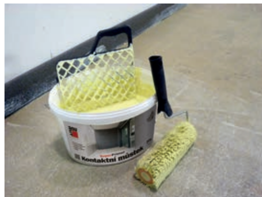
Nanesení základního nátěru Baumit SuperPrimer vč. osazení okrajových dilatací
