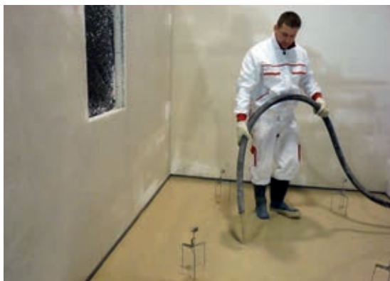
Lití potěru bez podlahového vytápění
