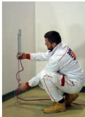
Zaměření nivelety a stanovení výšky podlahové konstrukce pomocí nivelačního laseru, hadicové vodováhy apod.
