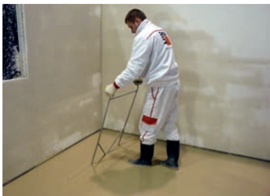
Vibrační lať a ježatý odvzdušňovací válec
