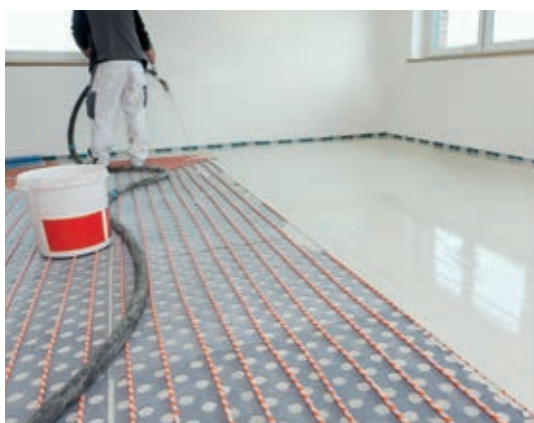
lití samonivelační stěrky Baumit Nivello Quattro / Nivello 20 / Nivello 30 / Nivello 50
