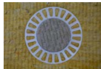
Příklad povrchové montáže hmoždinky pomocí prostorově tvarovaného širokého talířku
