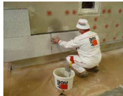
Obr. 41 - Lepení tepelněizolační desky
