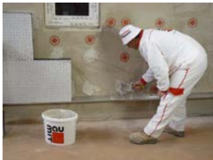
Obr. 39 - Nanášení lepidla na kotvy StarTrack
