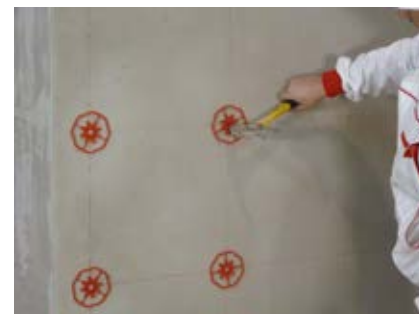
Obr. 38 - Aktivace kotvy StarTrack Red
