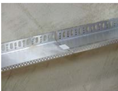
Obr. 14 – Spojka soklových lišt PV 30
