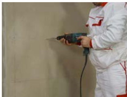
Obr. 37 - Vrtání otvorů pro kotvy
