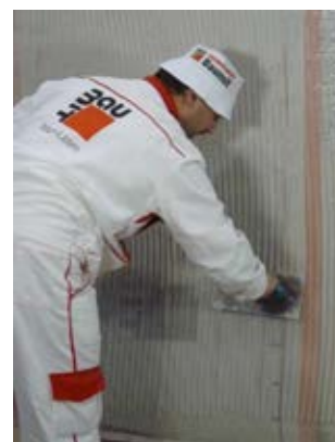
Obr. 31 - Dodatečné vyztužení
