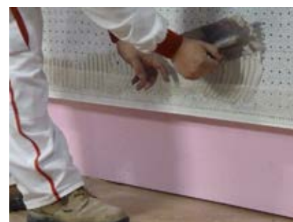
Obr. 15 – Okapnička k soklovému profilu ETICS
