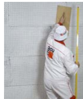
Obr. 21 – Broušení fasádních desek
