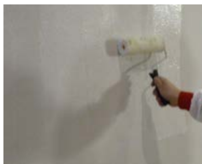
Obr. 34 – Provádění základního nátěru
