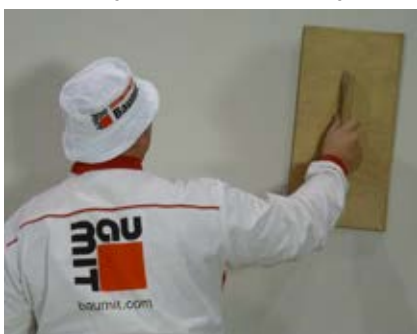
Obr. 33 – Broušení základní vrstvy
