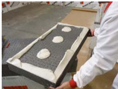
Obr. 40 - Nanášení lepidla na tepelněizolační desku
