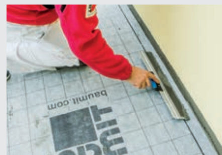
Vylisování lepidla a vzduchových bublin
