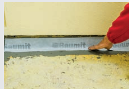
Utěsnění styku podlahy a stěny
