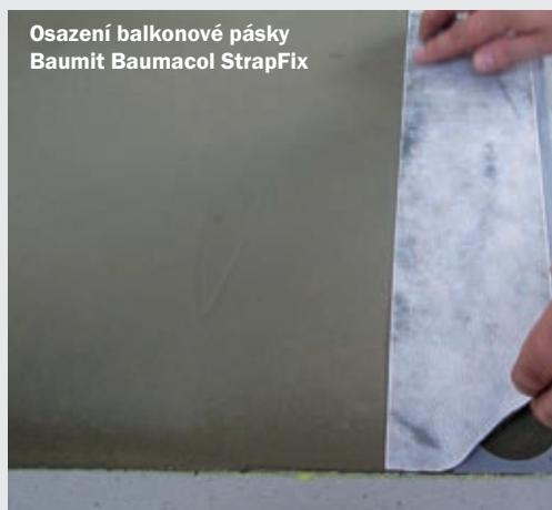
Osazení hydroizolační pásky Baumit Baumacol Strap Plus
