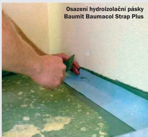
Osazení balkonové pásky Baumit Baumacol StrapFix
