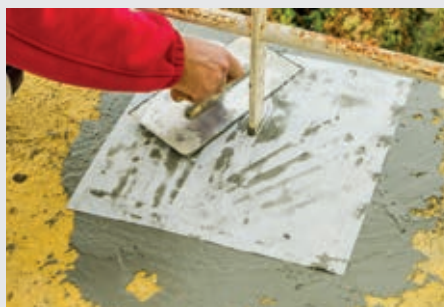
Utěsnění prostupů pomocí hydroizolační bandáže
