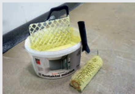
Nanesení systémového kontaktního můstku
