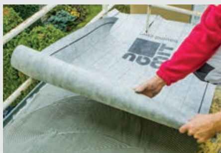
Celoplošná aplikace lepidla
