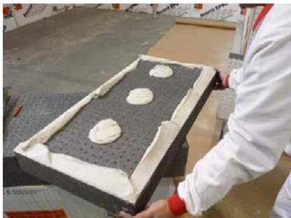
Obr. 39 – Nanášení lepidla na tepelněizolační desku
