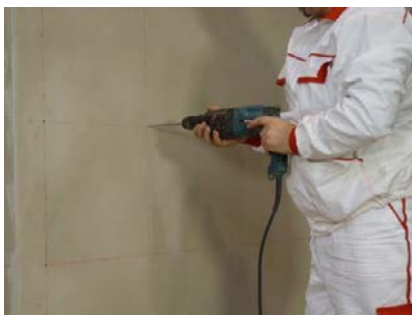
Obr. 36 – Vrtání otvorů pro kotvy
