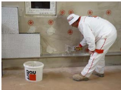
Obr. 38 – Nanášení lepidla na kotvy StarTrack
