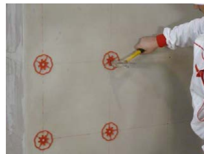
Obr. 37 – Aktivace kotvy StarTrack Red
