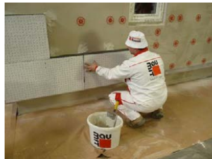
Obr. 40 – Lepení tepelněizolační desky
