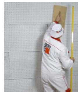
Obr. 21 – Broušení fasádních desek
