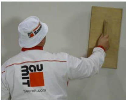
Obr. 32 – Broušení základní vrstvy
