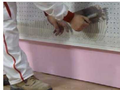
Obr. 15 – Okapnička k soklovému profilu ETICS
