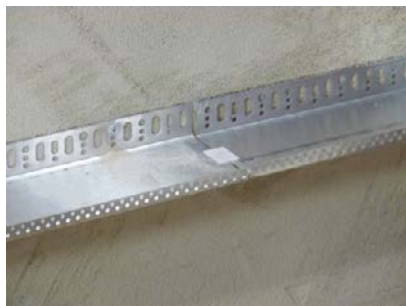
Obr. 14 – Spojka soklových lišt PV 30
