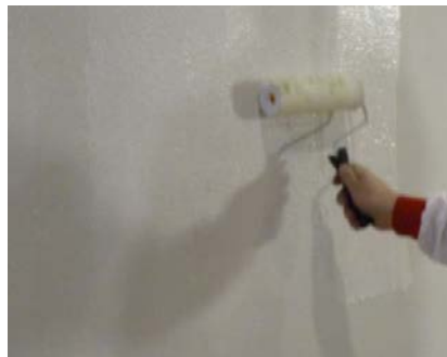
Obr. 33 – Provádění základního nátěru
