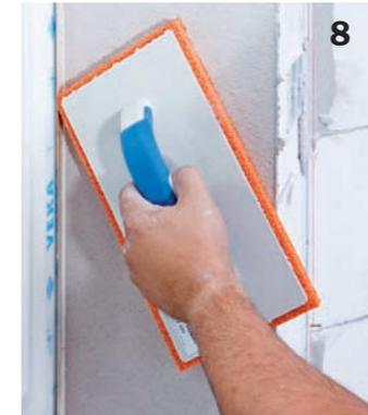
Pokud použijeme omítku na vyrovnávání stěn před stěrkováním, výše uvedený krok vynecháme a jen nahrubo povrch srovnáme do požadovaného tvaru. Stěrkování sádrovými stěrkami Baumit můžete provádět ihned po zatuhnutí na ještě vlhkém podkladu.
