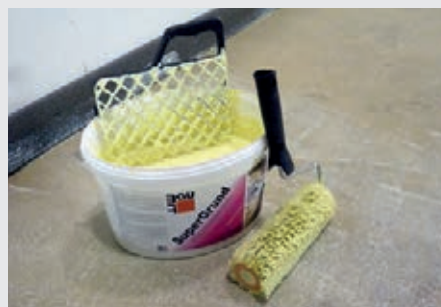
Nanesení systémového kontaktního můstku
