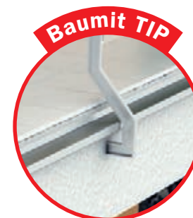
Zábradlí kotvíte z čela nebo spodního líce konstrukce.
