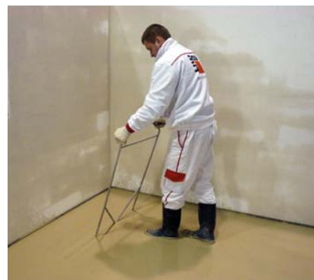
Odvzdušnění litého potěru vibrační latí
