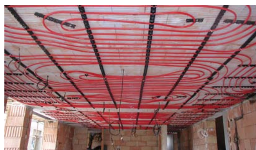
Stropní vytápění/chlazení
