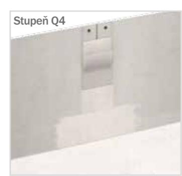
V případě, že se při přejímce má brát ohled na speciální světelné poměry např. „ploché světlo“ nebo umělé osvětlení, musí objednavatel zajistit, aby podobné světelné podmínky byly k dispozici již při provádění prací (tmelení).
