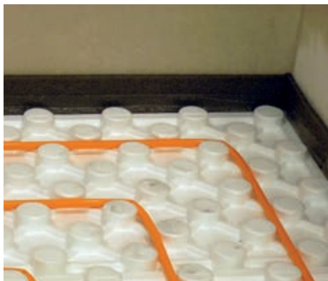
Příprava podkladu v podobě položení systému podlahové vytápění a osazení okrajové dilatační pásky
