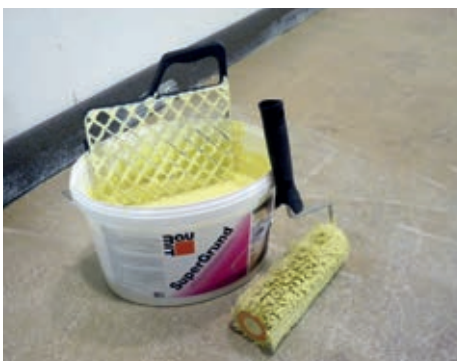
Naneseení základního nátěru v podobě kontaktního můstku Baumit SuperGrund
