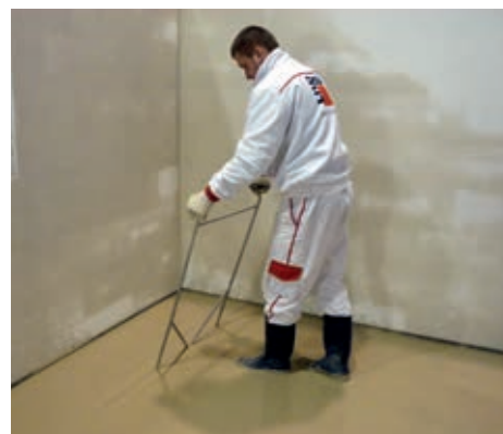
Odvzdušnění litého potěru vibrační latí. Odvzdušnění doporučujeme provádět dvakrát ve dvou směrech.
