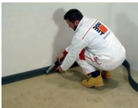
Při tl. stěrky >3mm je nutné osazení okrajových dilatačních pásek
