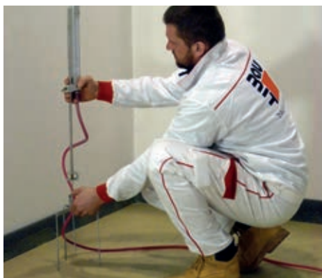
Zaměření nivelety a stanovení výšky podlahové konstrukce.
