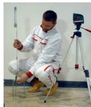
Zaměření nivelety a stanovení výšky podlahové konstrukce.
