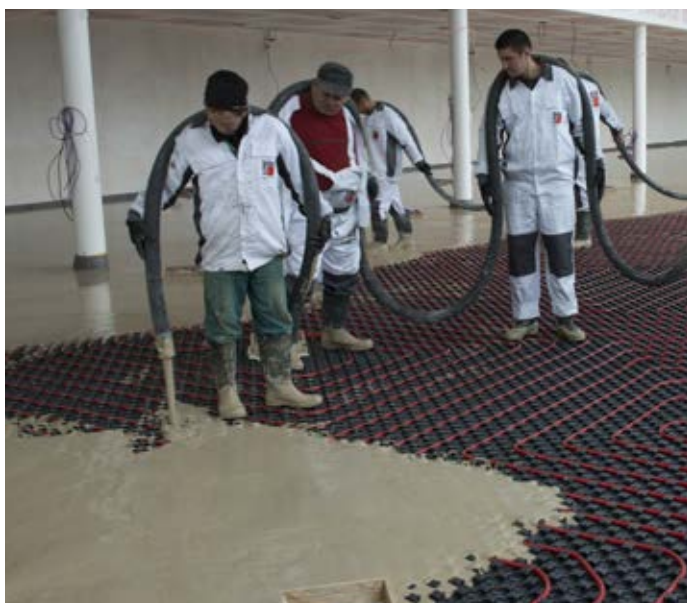
Příprava podkladu v podobě položení systému podlahové vytápění a osazení okrajové dilatační pásky
