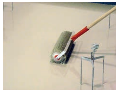
Odvzdušnění a rozprostření směsi ježatým válečkem .
