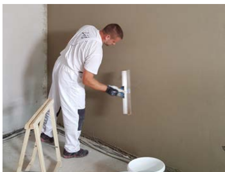
Obr. 4: Po zatuhnutí se povrch navlhčí a houbovým hladítkem (houbou) rozfilcuje. Po krátkém zaschnutí se houbovým či molitanovým hladítkem vytvoří finální štuková struktura.
