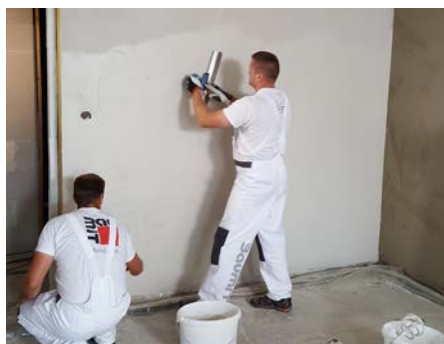
Obr. 5: Pro požadavek hladkých povrchů se nerezovým hladítkem aplikuje přírodně bílá vyhlazovací stěrka Baumit KlimaFino. V tomto případě se omítka nefilcuje, pouze se strhne do roviny viz obrázek č. 3.
