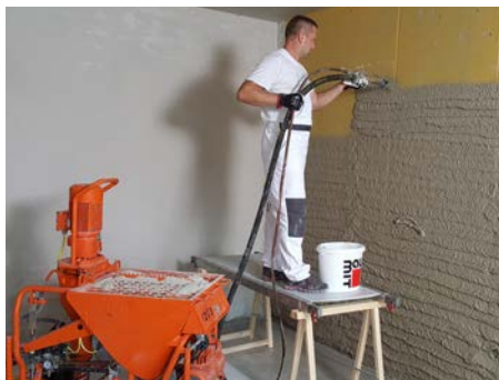
Obr. 1: Strojní omítky Baumit Klima se zpracovávají vhodným omítacím strojem. Na předem připravený podklad se materiál s požadovanou konzistencí stříká ve tvaru housenky.
