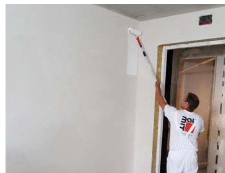
Obr. 6: Na vyzrálý povrch Klima omítek či stěrek se aplikuje paropropustná barva Baumit KlimaColor, která svou vysokou paropropustností podporuje funkci Baumit Klima omítkových systémů.
