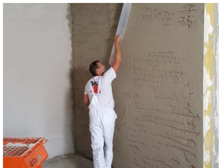
Obr. 2: Následně se povrch omítky nahrubo stahuje hliníkovou latí „h-profilu“ do roviny. Popřípadě se dostříkává materiál na požadovanou tloušťku vrstvy.
