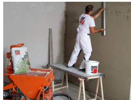
Obr. 3: Zavadnutý povrch omítky se následně seřízne trapézovou latí nebo nerezovou špachtlí. Tím se dosáhne požadované rovinnosti povrchu omítky.
