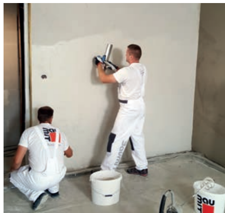
Obr. 5: Pro požadavek hladkých povrchů se nerezovým hladítkem aplikuje přírodně bílá vyhlazovací stěrka Baumit KlimaFino. V tomto případě se omítka nefilcuje, pouze se strhne do roviny viz obrázek č. 3.
