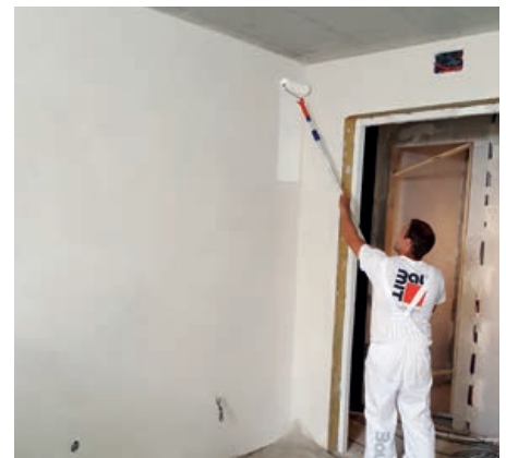
Obr. 6: Na vyvrážený povrch Klima omítek či stěrek se aplikuje paropropustná barva Baumit KlimaColor, která svou vysokou paropropustností podporuje funkci Baumit Klima omítkových systémů.
