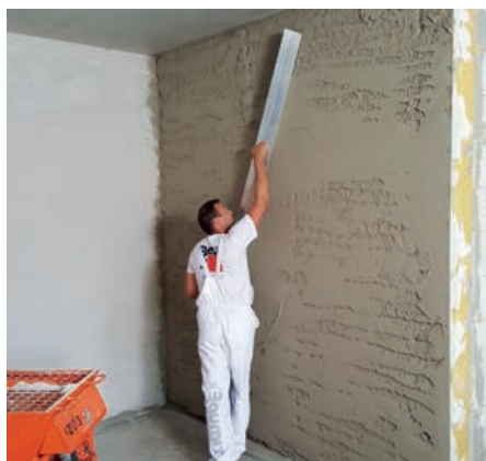
Obr. 2: Následně se povrch omítky nahrubo stahuje hliníkovou latí „h-profilu“ do roviny. Popřípadě se dostřikává materiál na požadovanou tloušťku vrstvy.
