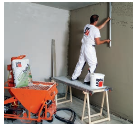
Obr. 3: Zavadnutý povrch omítky se následně seřízne trapézovou latí nebo nerezovou špachtlí. Tím se dosáhne požadované rovinnosti povrchu omítky.
