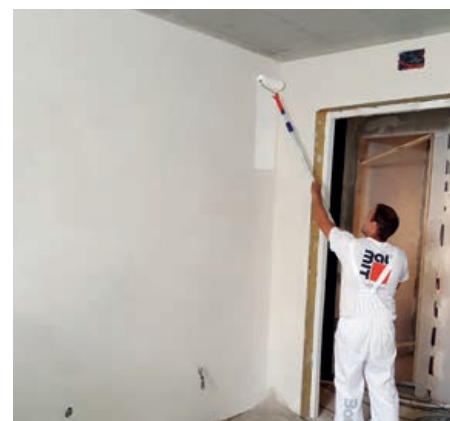
Obr. 6: Na vyztvrálý povrch Klima omítek či stěrek se aplikuje paropropustná barva Baumit KlimaColor, která svou vysokou paropropustností podporuje funkci Baumit Klima omítkových systémů.
