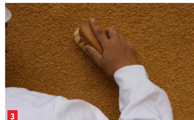
3 Po technologické přestávce 12 hodin, fasádu mechanicky očistěte.
