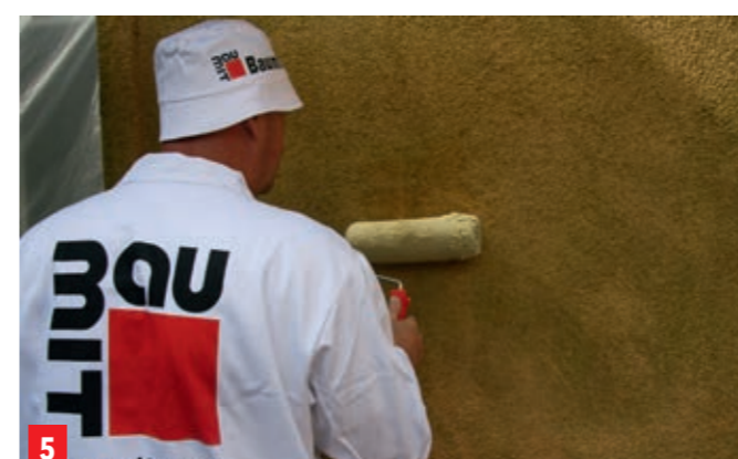
5 Na suchý povrch aplikujte celoplošně jeden nátěr Baunit FungoFluid. Min. 12 hodin chraňte před deštěm.
