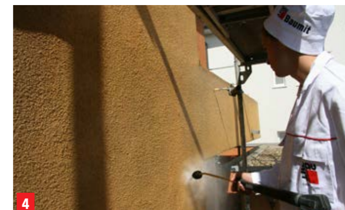
4 Fasádu důkladně očistěte vodou, odpad odstraňte, povrch nechte vyschnout.
