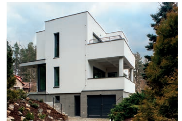
Rekonstrukce vily, Hradec, Stříbrná Skalice
