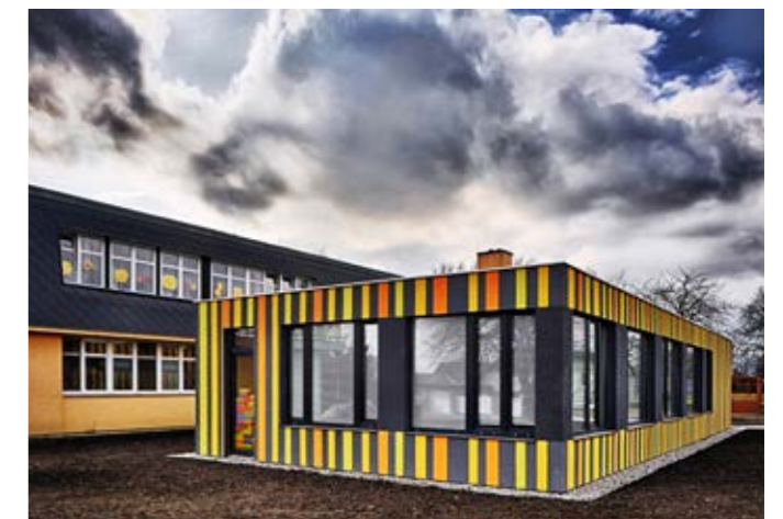
Mateřská škola, Kamenný Újezd
