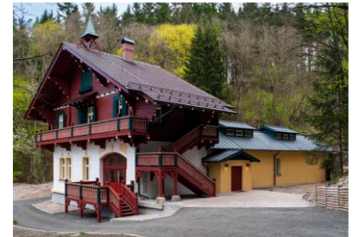
Löschnerův mlýn, Kyselka u Karlových Varů - rekonstrukce a přestavba na muzeum
