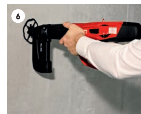
6 Přiložte ke zdi – přitlačte vsazovací přístroj a zmáčkněte spoušť. Lepicí kotva Baumit StarTrack X1 je osazena!
