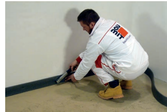
Obrázek 13: Dodržení zásad dilatací
