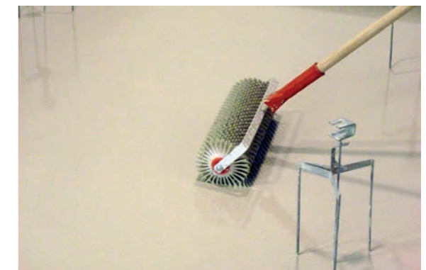
Obrázek 18: Odvzdušení směsi ježatým válečkem
