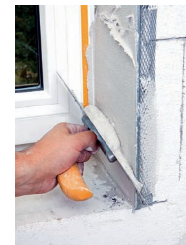
Obrázek 8: Natažení na řešené ostění/ nadpraží
