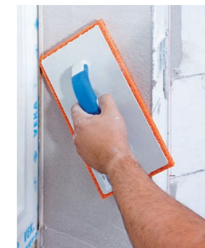
Obrázek 9: Vytvoření finální struktury (hlazený/ filcovaný povrch)
