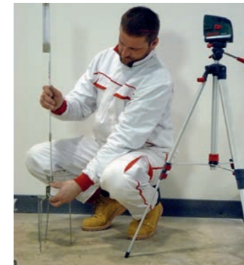
Obrázek 15: Nastavení a rozměření výšek
