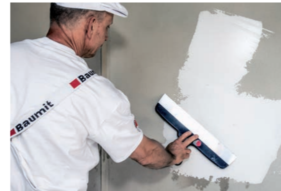
Obrázek 5: Ruční nanášení stěrkových materiálů, podklad beton/ sádrokarton
