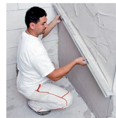
Obrázek 2: Natažení omítkové směsi
