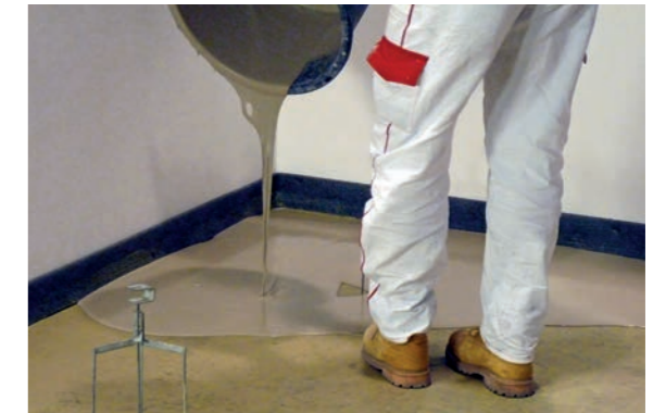
Obrázek 16: Vylití směsi v předepsané konzistenci
