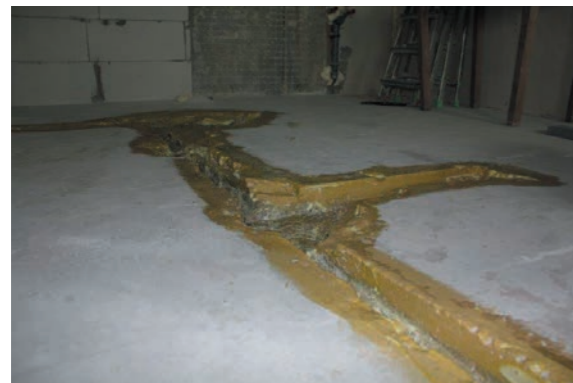
Obrázek 10: Podklad pro vyrovnání opatřený kontaktním můstkem
