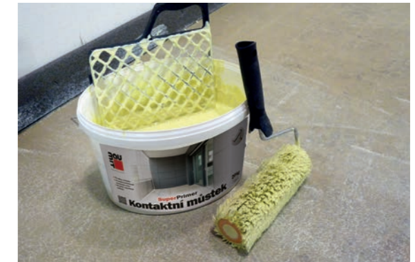
Obrázek 14: Nanesení systémového kontaktního můstku
