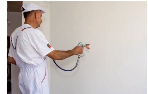
Obrázek 6: Strojní nanášení stěrkových materiálů
