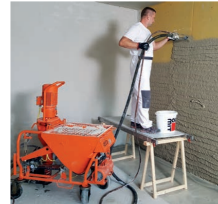
Obr. 1: Strojní omítky Baumit Klima se zpracovávají vhodným omítacím strojem. Na předem připravený podklad se materiál s požadovanou konzistencí stříká ve tvaru housenky.
