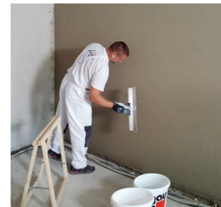
Obr. 4: Po zatuhnutí se povrch navlhčí a houbovým hladítkem (houbou) rozfilcuje. Po krátkém zaschnutí se houbovým či molitanovým hladítkem vytvoří finální štuková struktura.
