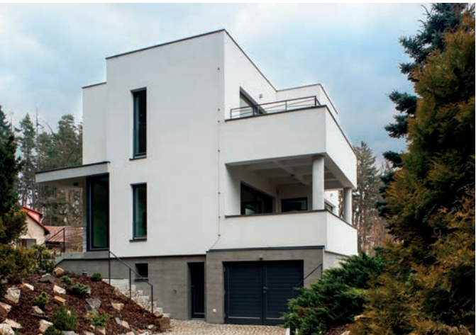
Rekonstrukce vily, Hradec, Stříbrná Skalice
