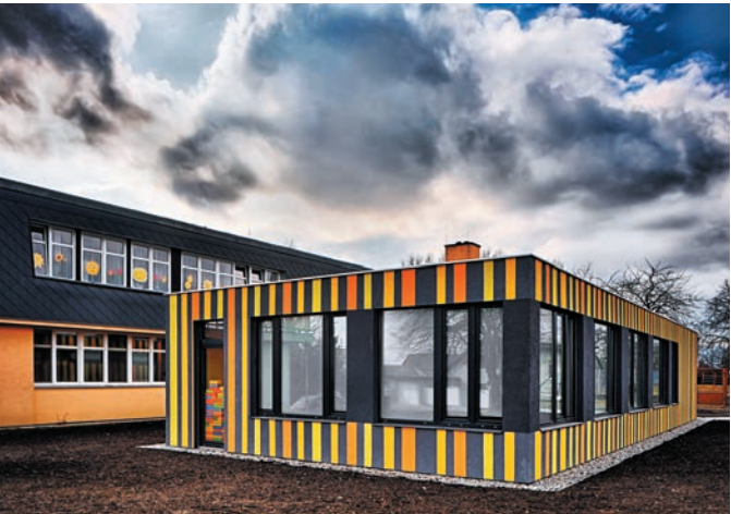
Mateřská škola, Kamenný Újezd
