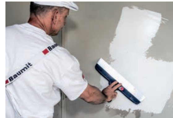
Obrázek 5: Ruční nanášení stěrkových materiálů, podklad beton/ sádrokarton
