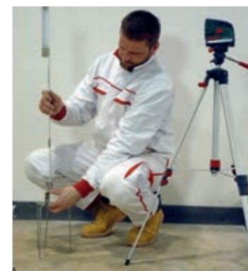
Obrázek 15: Nastavení a rozměření výšek
