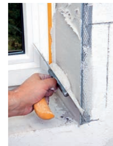
Obrázek 8: Natažení na řešené ostění/ nadpraží
