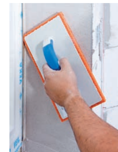
Obrázek 9: Vytvoření finální struktury (hlazený/ filcovaný povrch)
