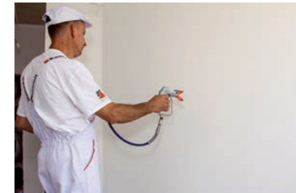
Obrázek 6: Strojní nanášení stěrkových materiálů
