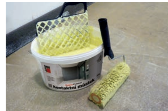
Obrázek 14: Nanesení systémového kontaktního můstku
