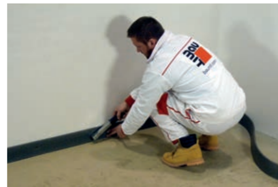
Obrázek 13: Dodržení zásad dilatací
