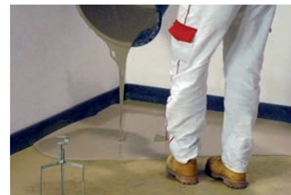
Obrázek 16: Vylití směsi v předepsané konzistenci
