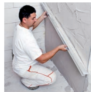
Obrázek 2: Natažení omítkové směsi
