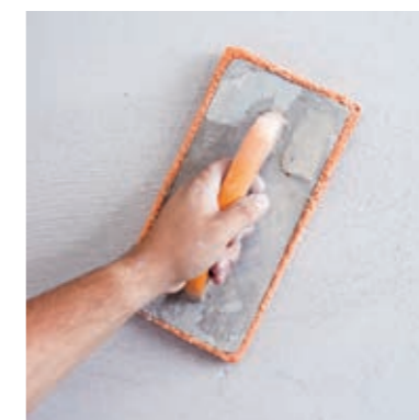
Obrázek 3: Vyrovnání omítky v ploše a vytažení jemného šlemu
