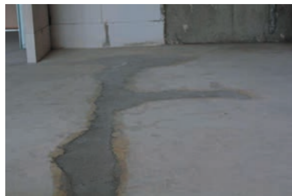
Obrázek 11: Zapravení prohlubně vyrovnávací maltou Baumit Baumacol Preciso Speed
