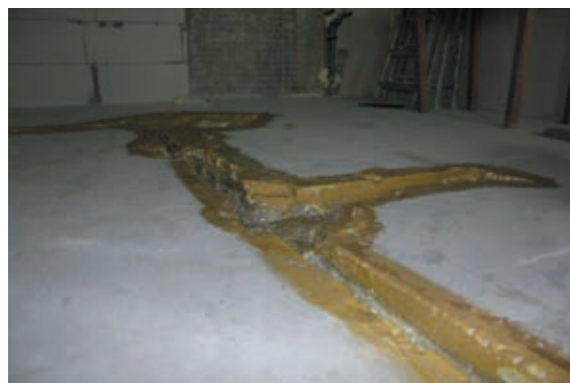
Obrázek 10: Podklad pro vyrovnání opatřený kontaktním můstkem
