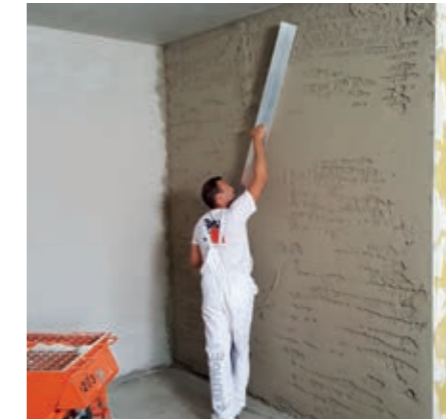
Obr. 2: Následně se povrch omítky nahrubo stahuje hliníkovou latí „h-profilu“ do roviny. Popřípadě se dostříká materiál na požadovanou tloušťku vrstvy.
