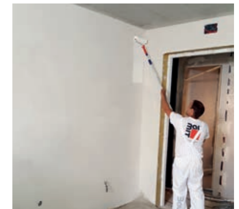
Obr. 6: Na vyzrálý povrch Klima omítek či stěrek se aplikuje paropropustná barva Baumit KlimaColor, která svou vysokou paropropustností podporuje funkci Baumit Klima omítkových systémů.
