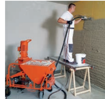
Obr. 1: Strojní omítky Baumit Klima se zpracovávají vhodným omítacím strojem. Na předem připravený podklad se materiál s požadovanou konzistencí stříká ve tvaru housenky.
