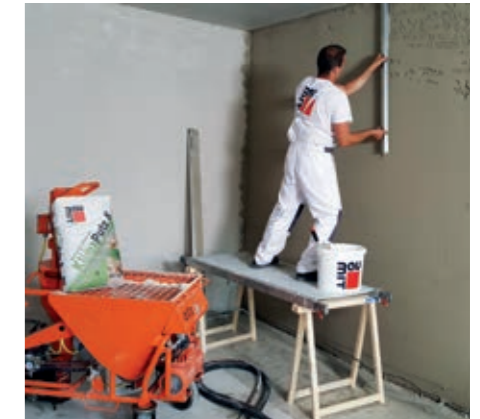
Obr. 3: Zavadnutý povrch omítky se následně seřízne trapézovou latí nebo nerezovou špachtlí. Tím se dosáhne požadované rovinnosti povrchu omítky.
