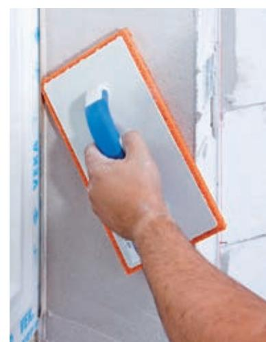
Obrázek 9: Vytvoření finální struktury (hlazený/ filcováný povrch)
