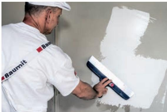
Obrázek 5: Ruční nanášení stěrkových materiálů, podklad beton/ sádrokarton
