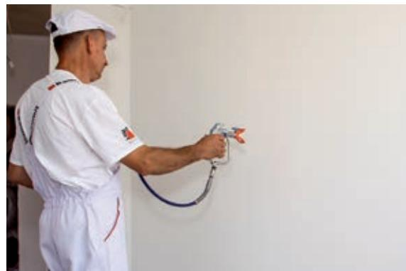
Obrázek 6: Strojní nanášení stěrkových materiálů
