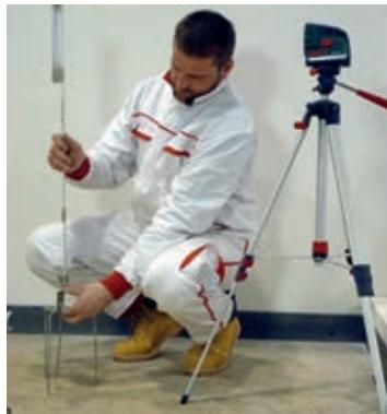
Obrázek 15: Nastavení a rozměření výšek
