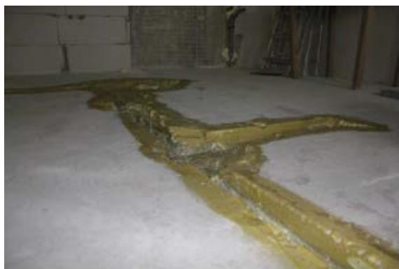
Obrázek 10: Podklad pro vyrovnání opatřený kontaktním můstkem
