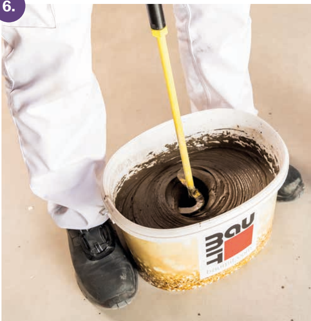
Rozmíchání lepicí malty Baunit Baumacol FlexTop Speed pro zrychlený proces lepení obkladů a dlažeb
