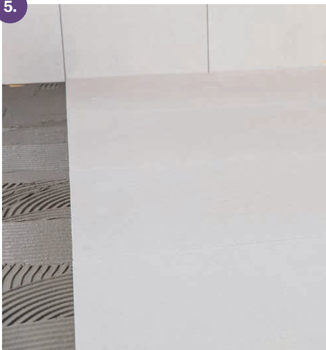
Usazení velkoformátové dlažby do lepicí malty
