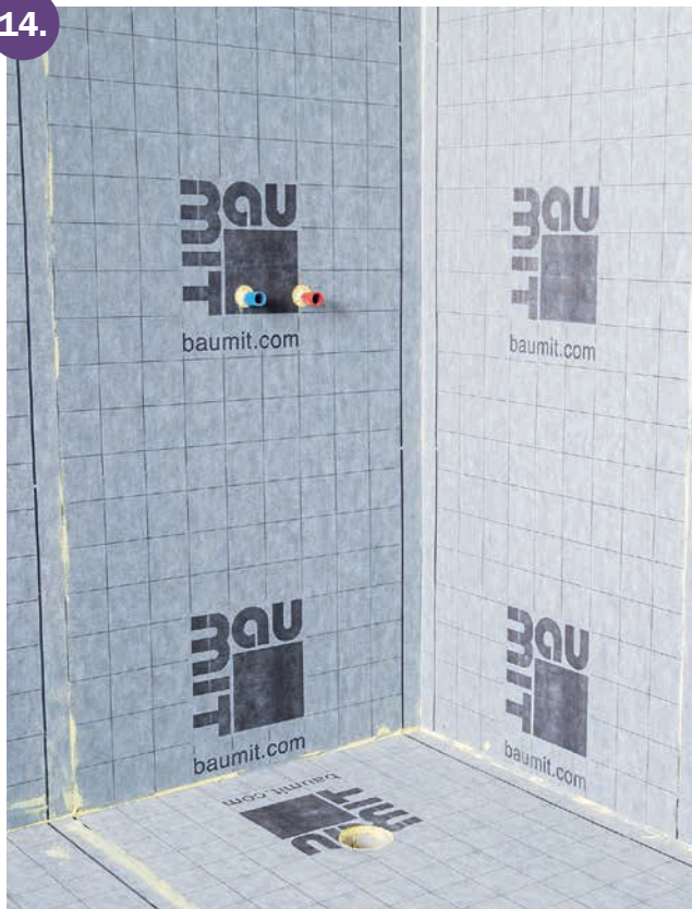
Hydroizolační folie Baumit AquaSafe – finální pohled
