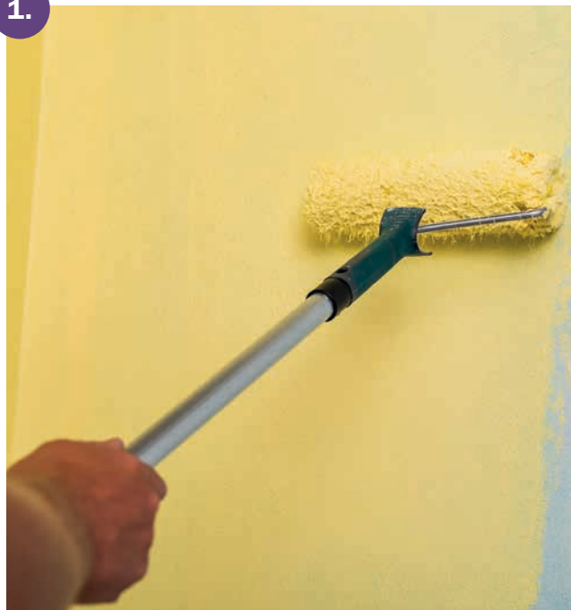
Nanášení kontaktního můstku Baumit SuperPrimer
