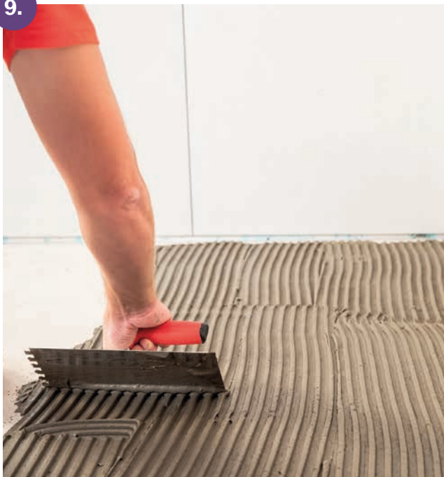
Nanesení na podlahovou strukturu
