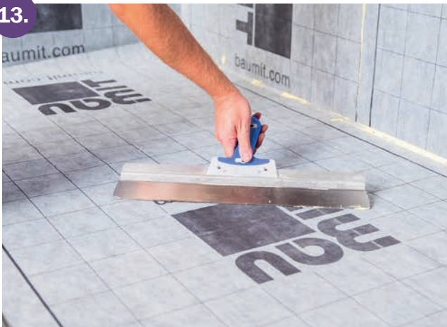
Vtlačení hydroizolační folie do lepicí malty Baumit Baumacol FlexTop Speed
