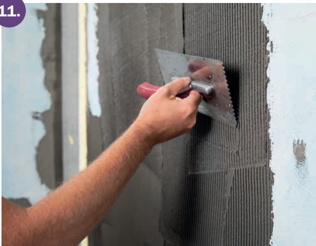
Příprava na aplikaci hydroizolační folie Baumit AquaSafe
