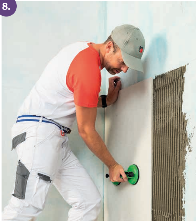
Usazení velkoformátového obkladu
