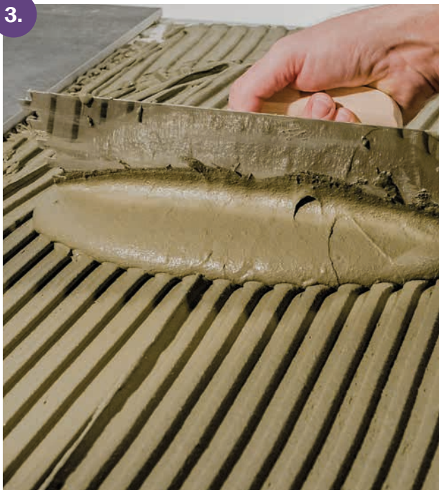
Nanášení lepicí malty Baunit Baumacol FlexUni Gel na podlahovou strukturu
