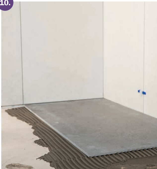
Usazení velkoformátové dlažby
