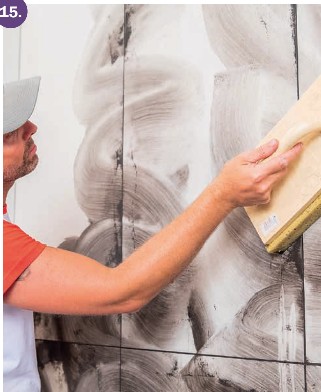
Spárování velkoformátového obkladu
