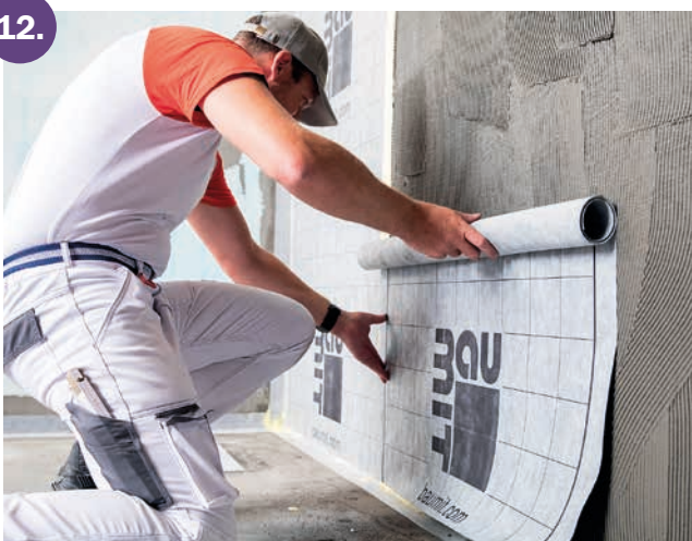
Instalace hydroizolační folie pro zrychlený proces lepení obkladů a dlažby
