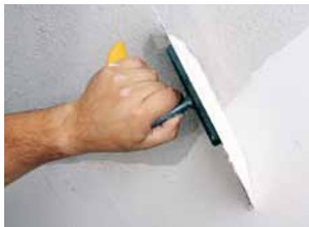
Nanesení nerezovým hladítkem
