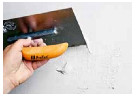
Lokální oprava nerovnosti povrchu
