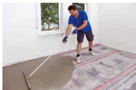
Baumit Nivello 50 – aplikace stěrky
