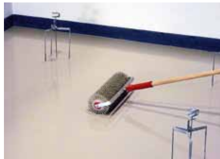
Baumit Alpha – provzdušnění ježatým válečkem
