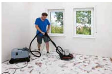
Příprava pro finální aplikaci Baumit Nivello 50 – broušení podkladu
