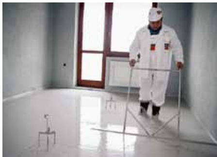
Baumit Alpha – práce s vibrační laťí
