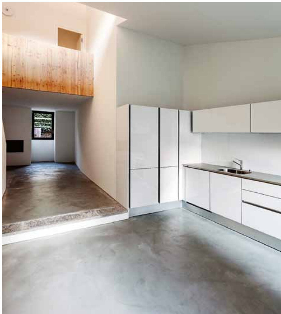
Ukázka realizace podlahy formou aplikace samonivelační stěrky
