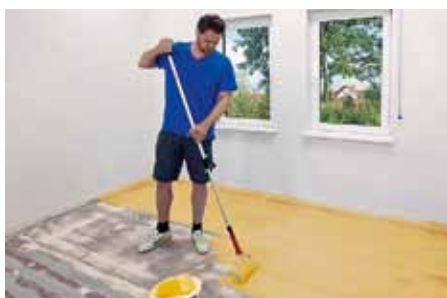
Příprava pro finální aplikaci Baumit Nivello 50 – aplikace kontaktního můstku
