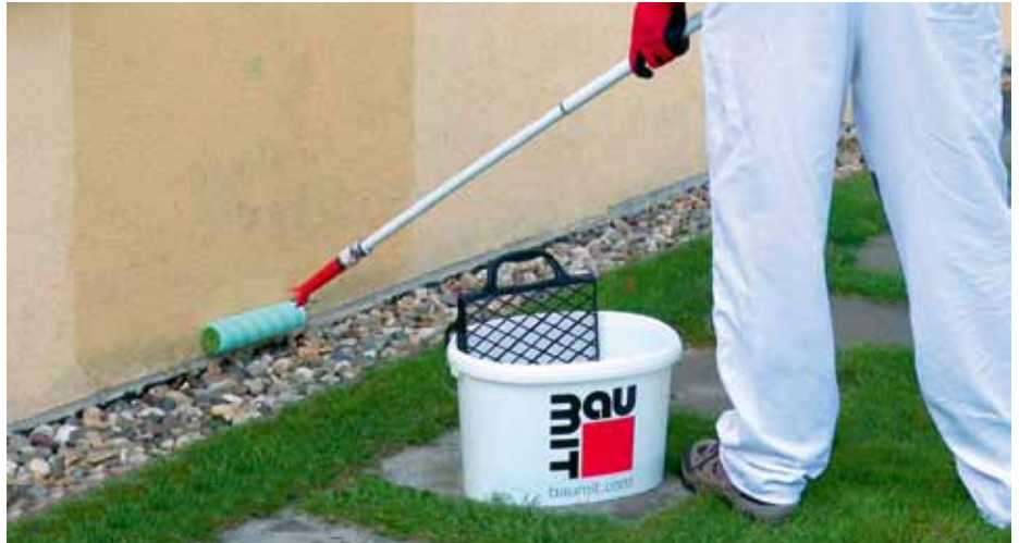
Nanášení penetračního nátěru Baumit MultiPrimer
