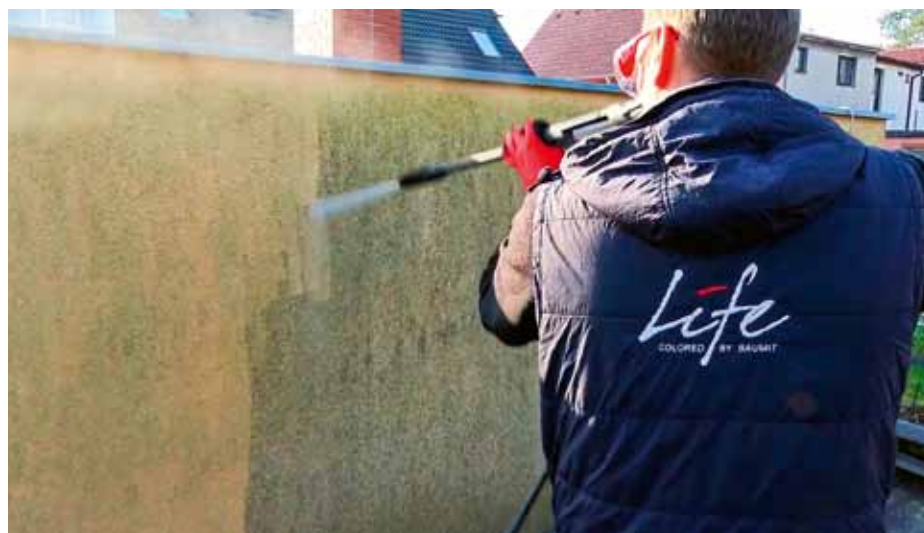
Oplach tlakovou vodou
