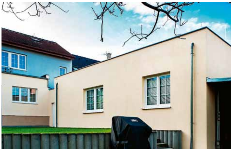
Objekt po obnově fasády
