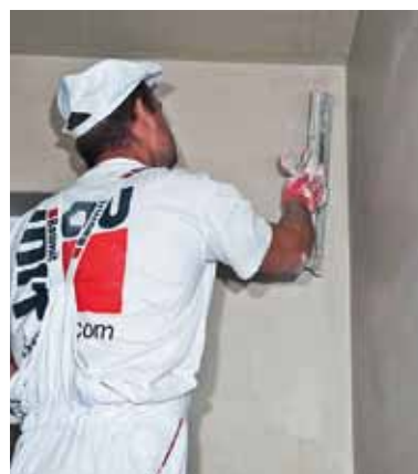
Proces hlazení vnitřních omítek Baumit Klima
