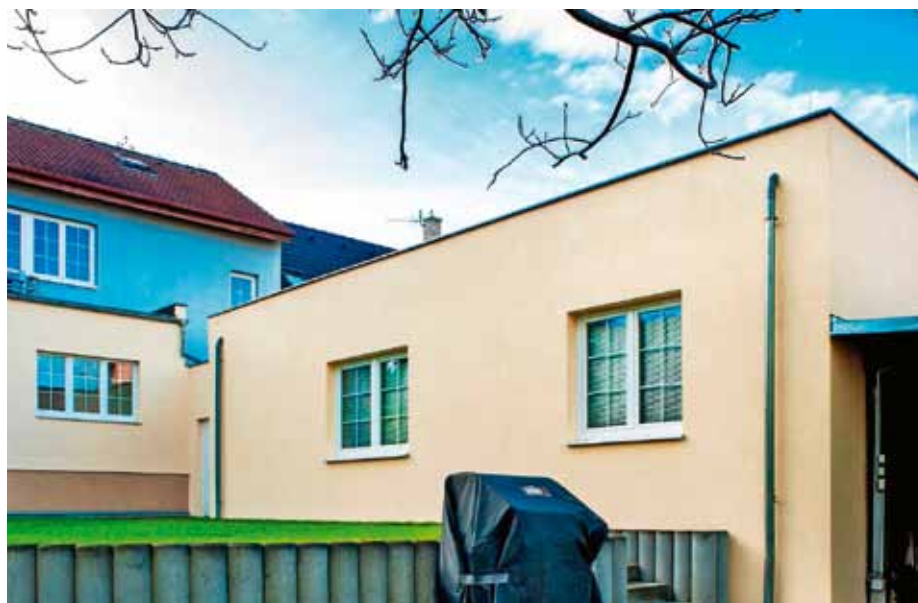
Objekt po obnově fasády
