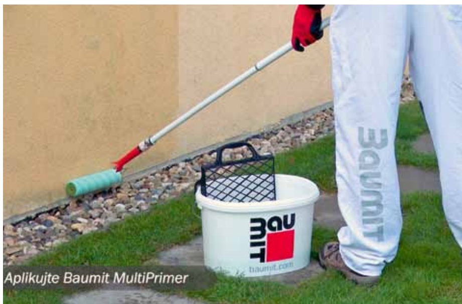
Nanášení penetračního nátěru Baumit MultiPrimer
