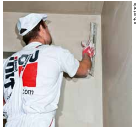
Proces hlazení vnitřních omítek Baumit Klima
