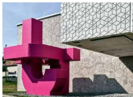
Renovace historického objektu: Friedensburg Schlaining Rakousko
