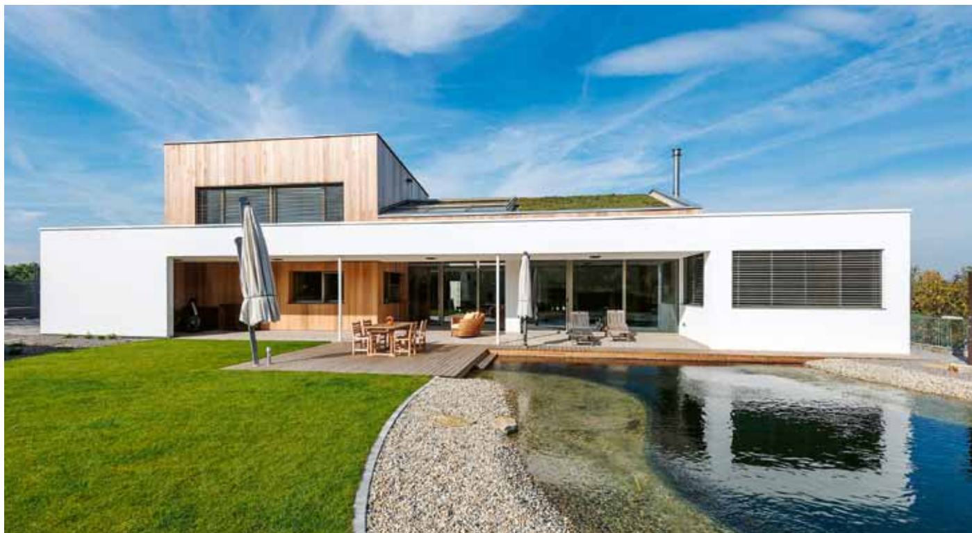
Realizace rodinného domu se zateplovacím systémem Baumit open
