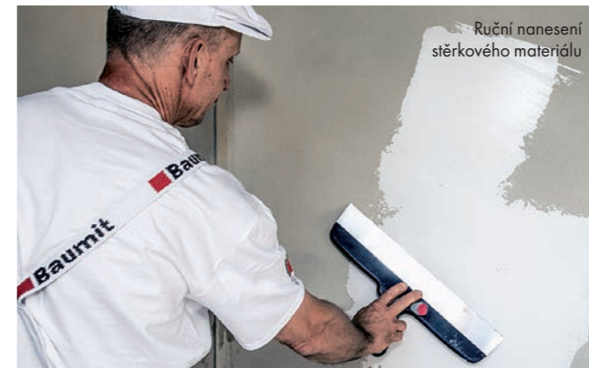
Nanesení nerezovým hladítkem
