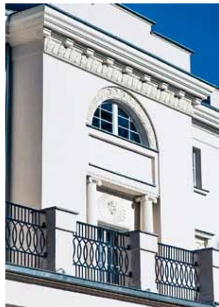
Systémy Baumit Sanova jsou difúzně otevřené a zajišťují rychlé odpařování vlhkosti z konstrukce
