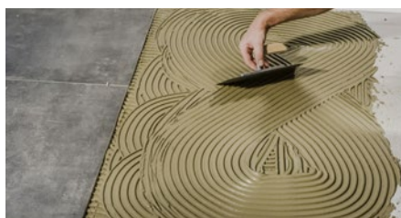
▲ Obr. 3 Baumit Baumacol FlexUni Gel – detail nanesení lepicí hmoty na podklad
