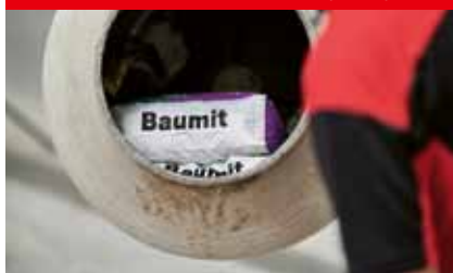
Míchání se samorozpustitelnými pytli
