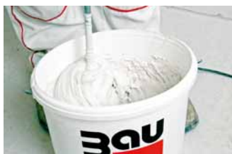
▲ Obr. 1 Připravená sádrová stěrka
