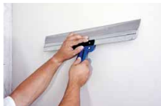
▲ Obr. 6 Finální stěrkování gletovací špachtlí
