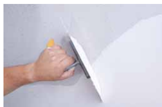
▲ Obr. 3 Nanášení nerezovým hladítkem
