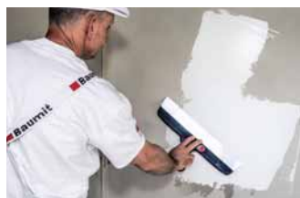
▲ Obr. 2 Ruční nanášení stěrkového materiálu
