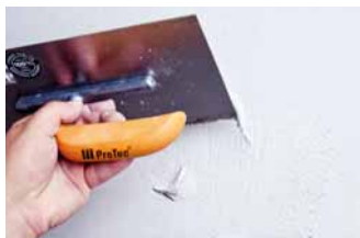
▲ Obr. 5 Lokální oprava nerovnosti povrchu
