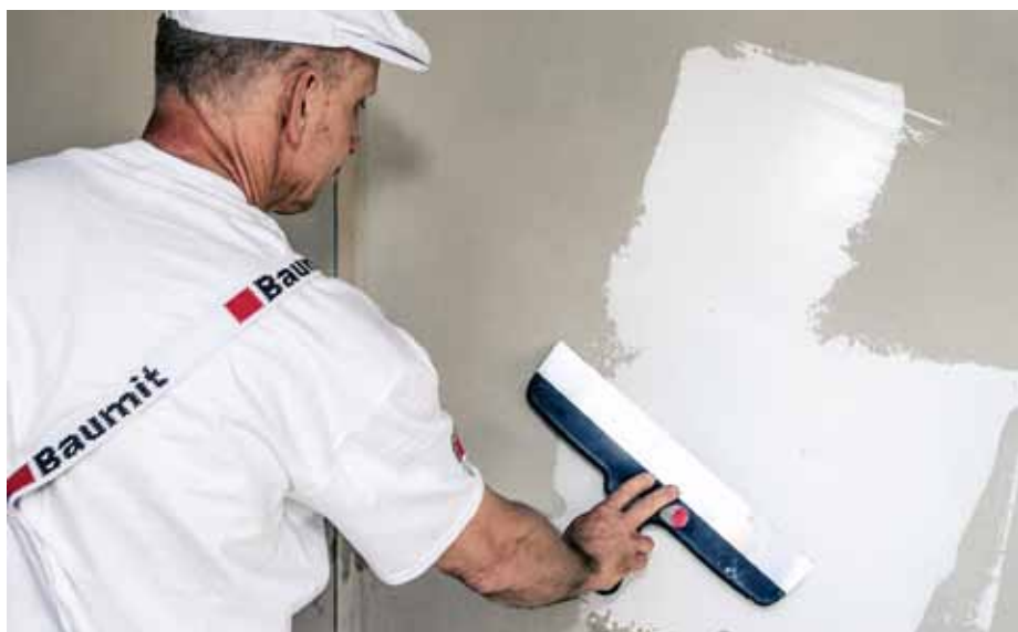
Ruční nanesení stěrkového materiálu
