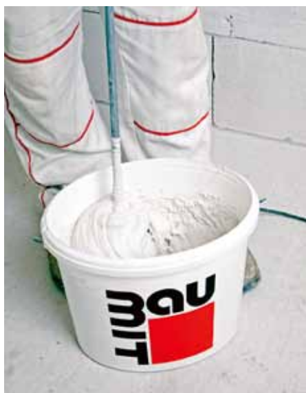
Příprava sádrové stěrky
