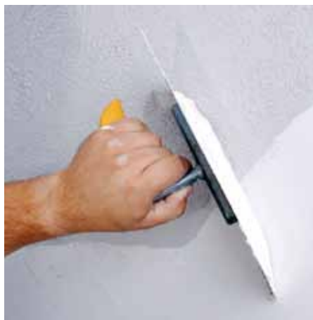
Nanesení nerezovým hladítkem
