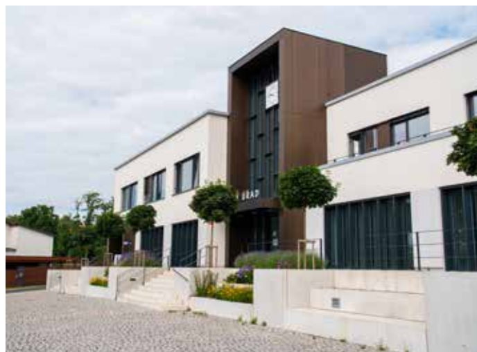
▲ Rekonstrukce objektu Kulturního střediska města Chlumec – II. etapa
