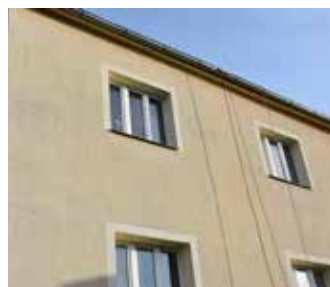
▲ Fasáda po mytí tlakovou vodou
