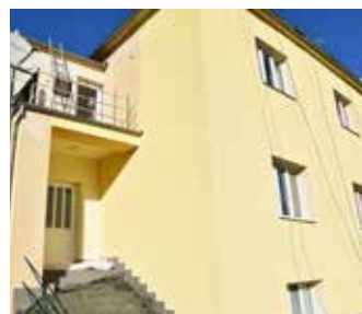
▲ Finální stav obnovy domu po dvou nátěrech fasádní barvou Baumit StarColor
