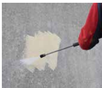
▲ Mytí fasády tlakovou vodou
