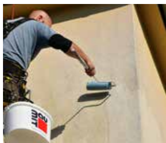
▲ Aplikace sanačního nátěru Baumit FungoFluid
