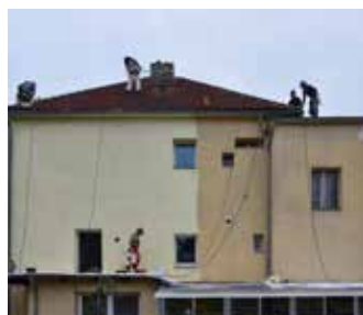
▲ Obnova domu po prvním nátěru fasádní barvou Baumit StarColor (levo) – porovnání s omytou fasádou (vpravo)
