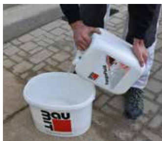
▲ Příprava na aplikaci sanačního nátěru Baumit FungoFluid
