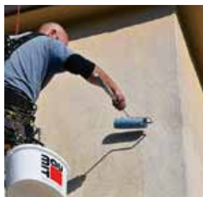
Aplikace sanačního nátěru Baumit FungoFluid
