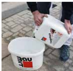
Příprava na aplikaci sanačního nátěru Baumit FungoFluid
