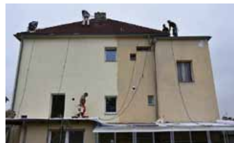
Obnova domu po prvním nátěru fasádní barvou Baumit StarColor (vlevo) – porovnání s omytou fasádou (vpravo)
