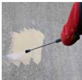
Mytí fasády tlakovou vodou
