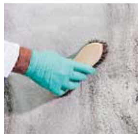
Detail čištění fasády kartáčem
