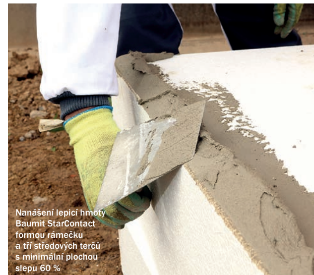
Lepení tepelněizolačních desek z EPS-F (minerální podklady není potřeba předem penetrovat)
