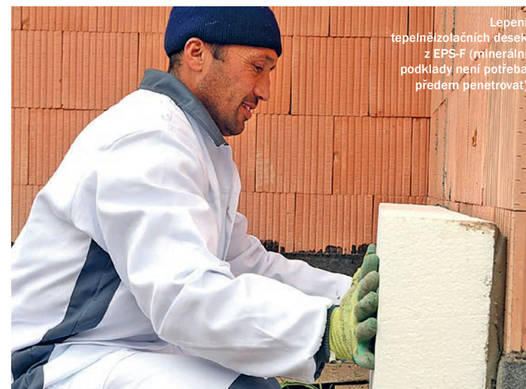
Nanášení lepicí hmoty Baumit StarContact formou rámečku a tří středových terčí s minimální plochou slepu 60 %
