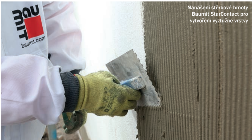
Vytváření výztužné vrstvy vložením sklotextilní síťoviny Baumit KeraTex
