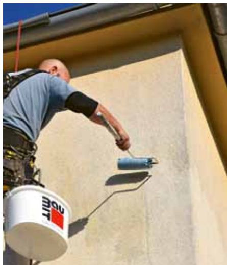
Aplikace sanačního nátěru Baumit FungoFluid
