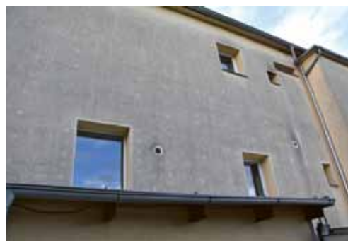
Příprava na aplikaci sanačního nátěru Baumit FungoFluid
