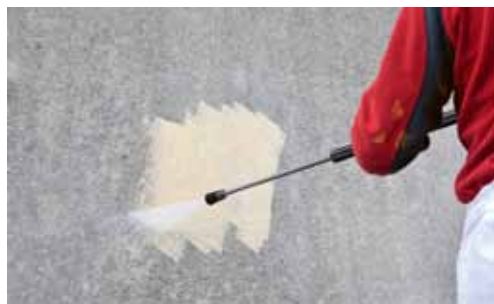
Mytí fasády tlakovou vodou
