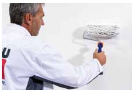
Nanášení penetračního nátěru
