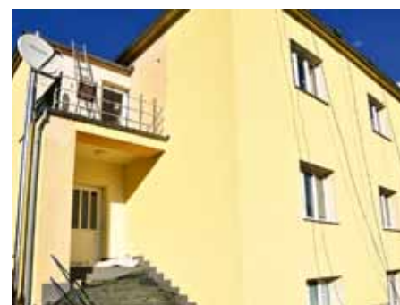
Finální stav obnovy domu po dvou nátěrech fasádní barvou Baumit StarColor
