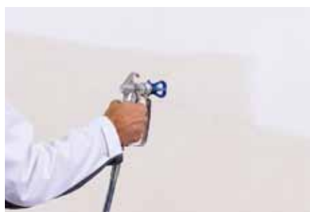
Nanášení fasádní barvy pomocí technologie airless
