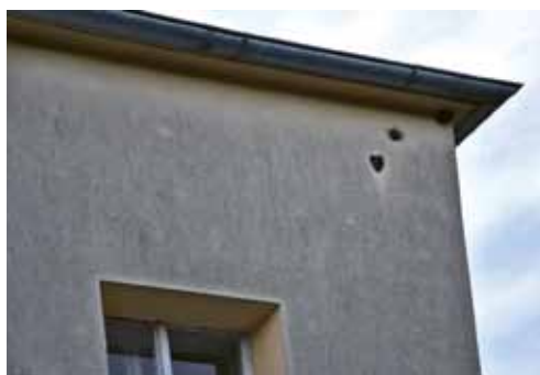
Fasáda po mytí tlakovou vodou
