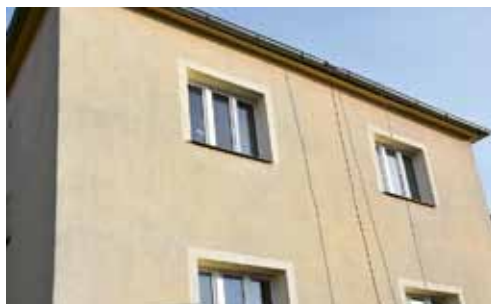
Fasáda po mytí tlakovou vodou
