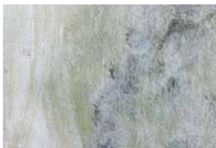
Biologické napadení fasády v detailu
