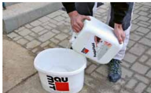
Příprava na aplikaci sanačního nátěru Baumit FungoFluid
