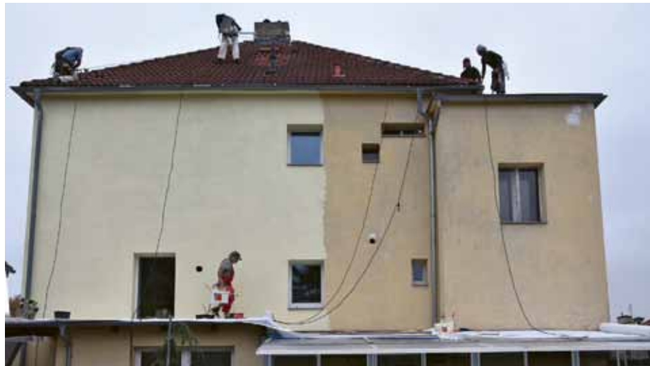
Obnova domu po prvním nátěru fasádní barvou Baumit StarColor (vlevo) – porovnání s omytou fasádou (vpravo)
