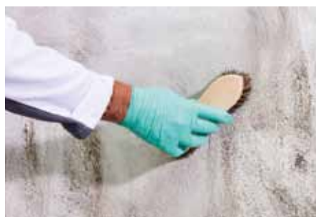
Detail čištění fasády kartáčem
