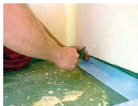
Osazení hydroizolační pásky
