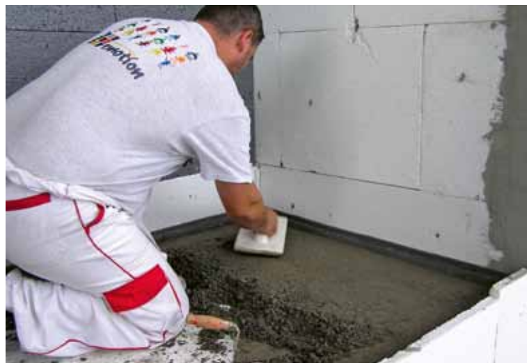
Příprava betonového potěru
