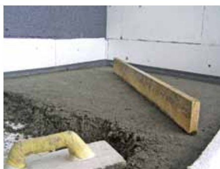
Realizace cementového potěru
