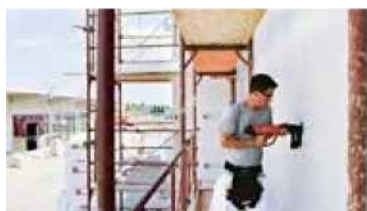
Baumit StarTrack X1 – instalace lepicí kotvy
