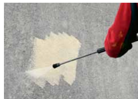
Mytí fasády tlakovou vodou
