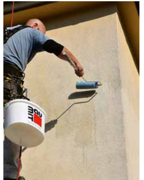
Nanášení sanačního nátěru Baumit FungoFluid
