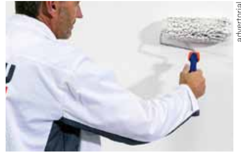
Nanášení penetračního nátěru
