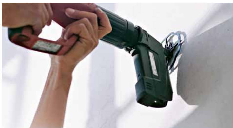
Instalace lepicí kotvy – detail
