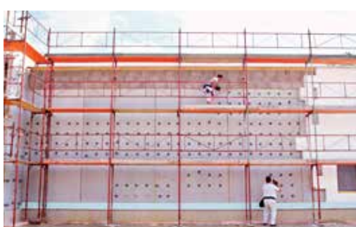
▲ Baumit StarTrack X1 – kotvení izolačních desek
