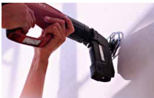
▲ Baumit StarTrack X1 – instalace lepicí kotvy, detail
