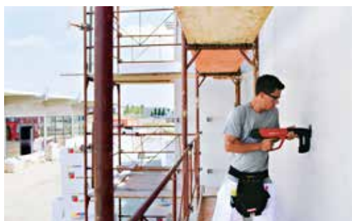
▲ Baumit StarTrack X1 – instalace lepicí kotvy
